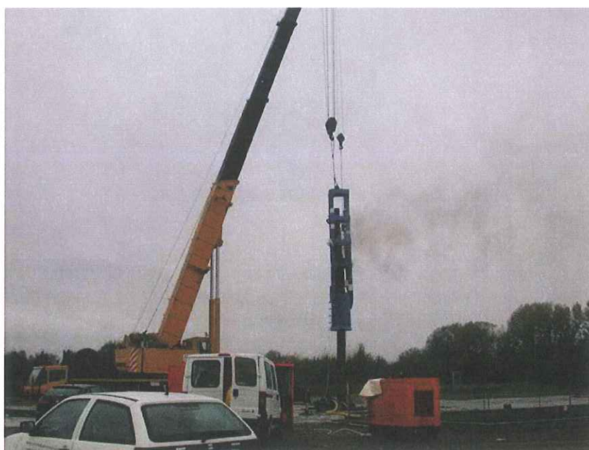
Foto 3. Vista del sistema d'infissione
