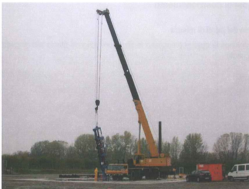
Foto 2. Vista del sistema d'infissione conductor pipe
